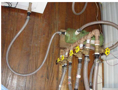
Figura 3-30. Ligação da bomba e barrilete com registros de controle de fluxo da CP
