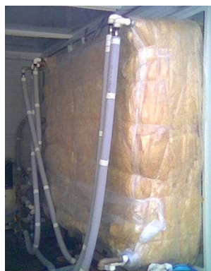
Figura 3-31. Isolamento das tubulações e das cavidades
