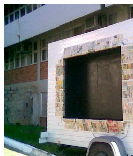
Figura 3-25. Pintura da cavidade principal
